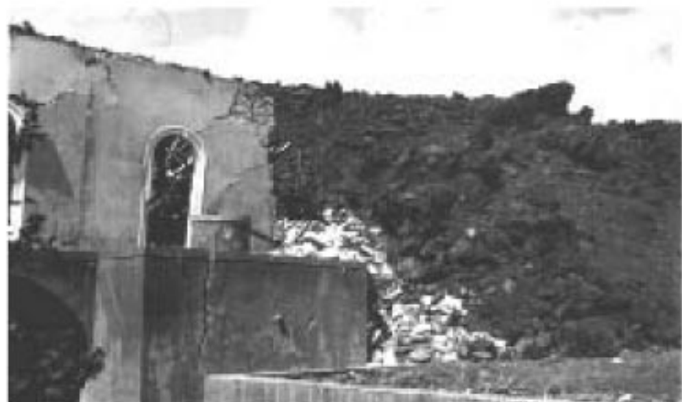
La lava alta più di 15 metri ha completamente distrutto una delle tante case di Catena Vecchia. (Foto Galifi-Grupi)
