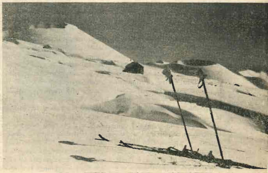
Monti Silvestri e Rifugio Saplenza Punto di congiungimento della strada Cassone con l'autostrada dell'Etna
